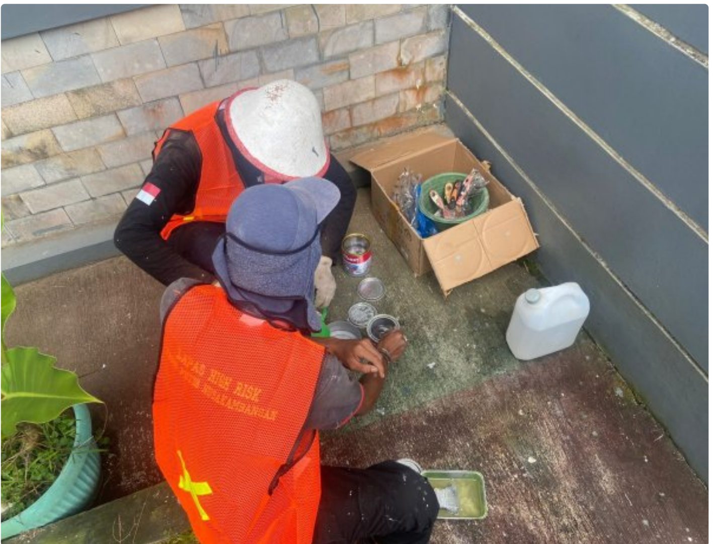
Pengecatan bangunan Lapas Pasir Putih oleh tenaga PPNN Lapas Pasir Putih
