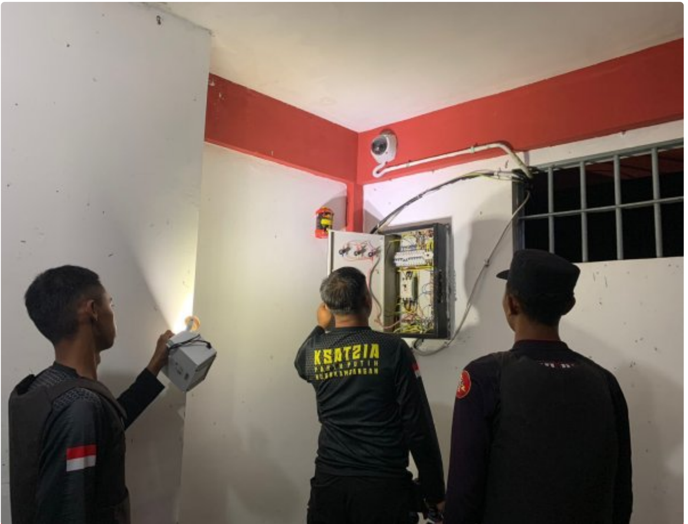
Pengecekan jaringan listrik antisipasi terjadinya korsleting listrik oleh petugas Lapas Pasir Putih
